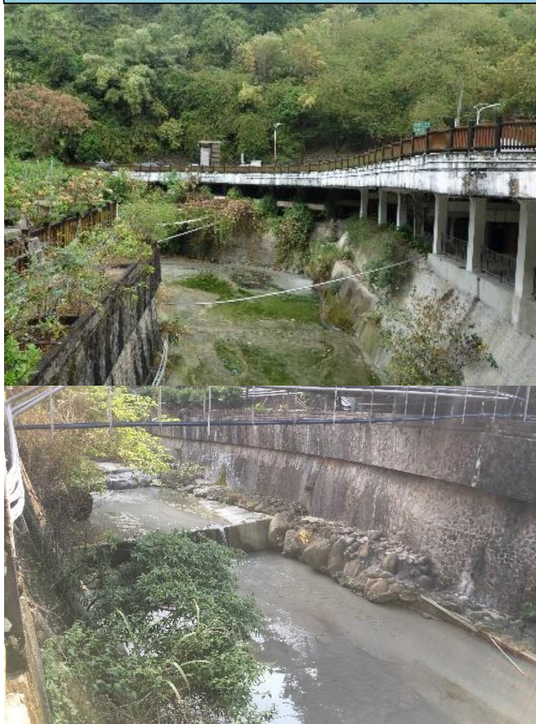
柚 子 頭 溪 護 岸 現 況
