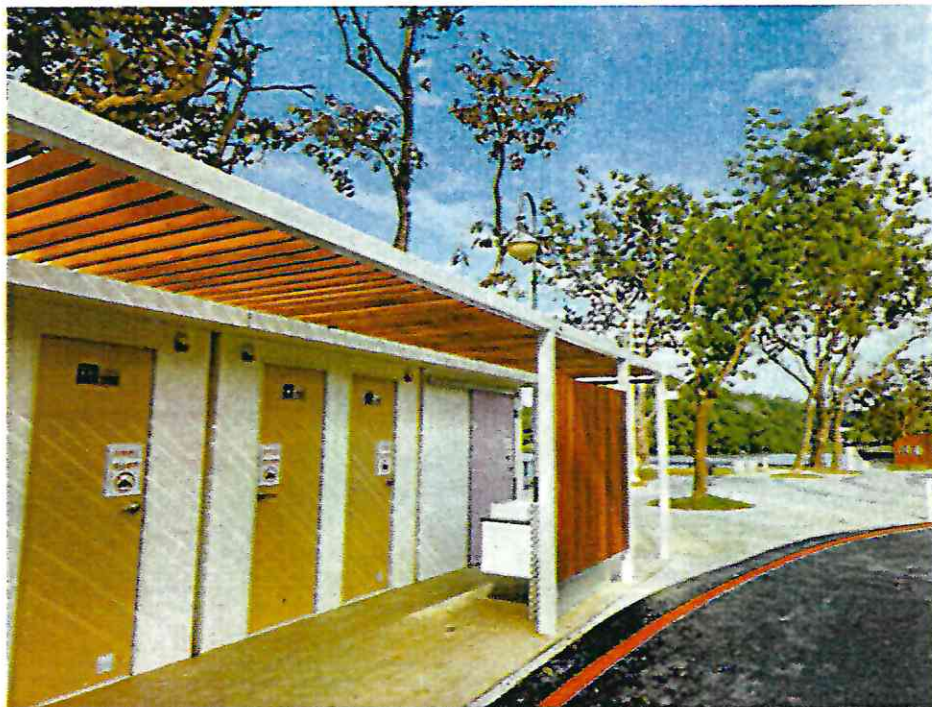
虎埤泛月環景生態遊憩設施優化工程-性別友善廁所
