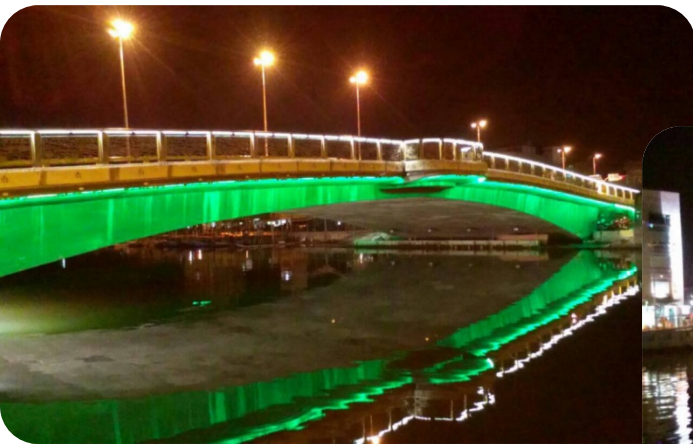
▲ 安億橋夜間照明景觀
