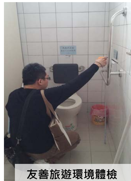
德元埤-無障礙廁所
