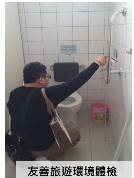
德元埤-無障礙廁所
